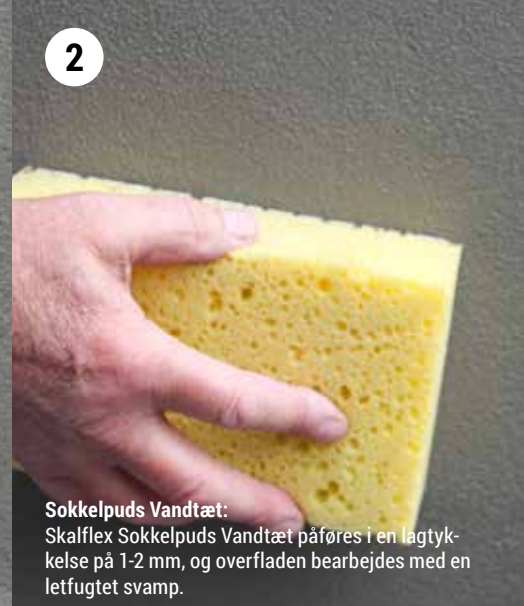
Sokkelpuds Vandtæt: Hvis det skønnes nødvendigt, kan den isolerede og netpudsede sokkel påføres et filtslag som afslutning. Underlaget forvandes.
