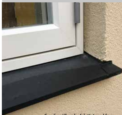
Færdig sålbænk afsluttet med fuge.
