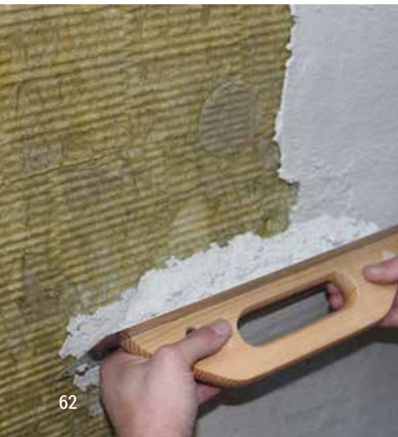
Igangværende facadeisolering inkl. sokkelisolering.
