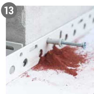
Dybelskruen placeres i borehullet.
